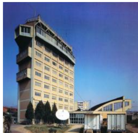
Figura 6 - Vecchia sede dell'IROE (Istituto di Ricerca sulle Onde Elettromagnetiche), oggi IFAC (Istituto di Fisica Applicata "Nello Carrara") del CNR di Firenze.
